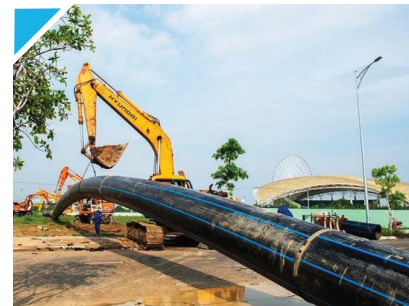
Dự án thi công tuyến ống HDPE D900 vượt sông Hàn - Đà Nẵng
